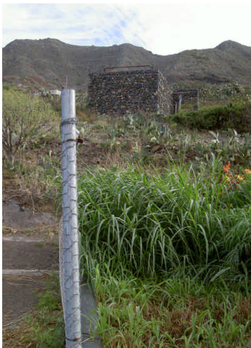
Foto nº 1: Vista del depósito cerrado
