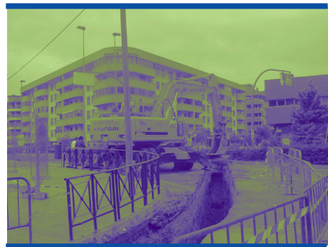
Retroexcavadora. Máquina para excavaciones de zanjas y agujeros verticales
